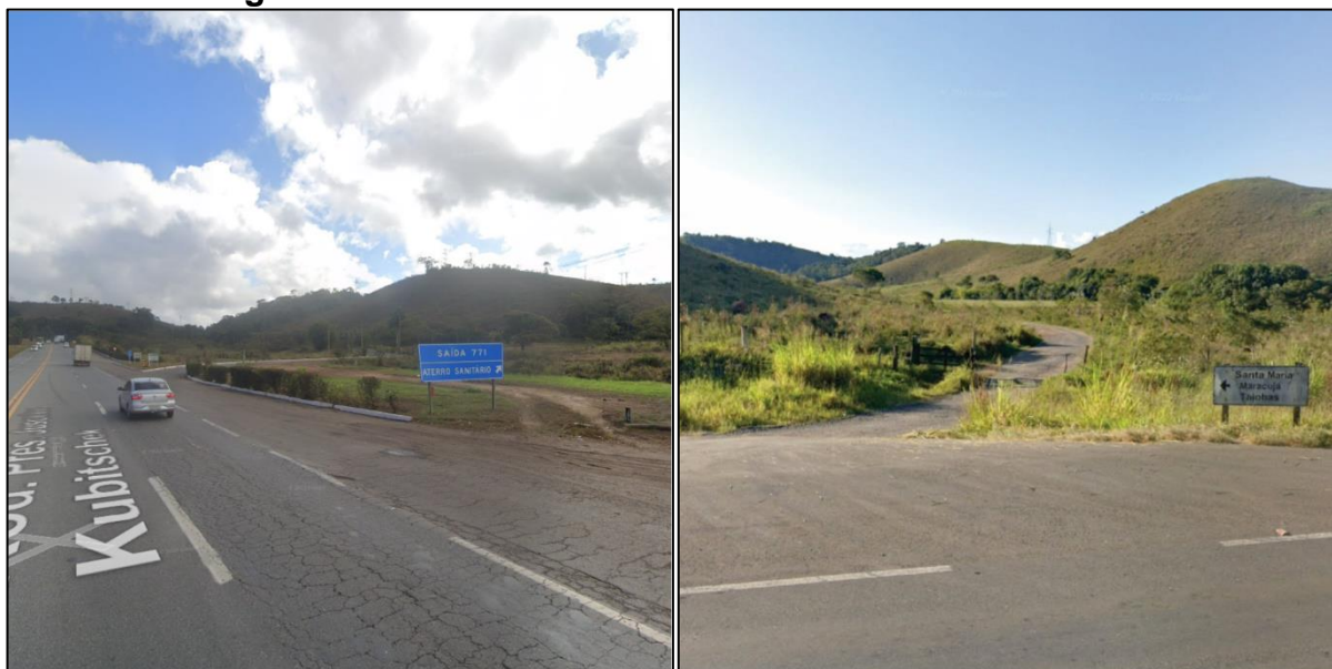
Figura 51 – Fotos da via de acesso ao Aterro Sanitário.
