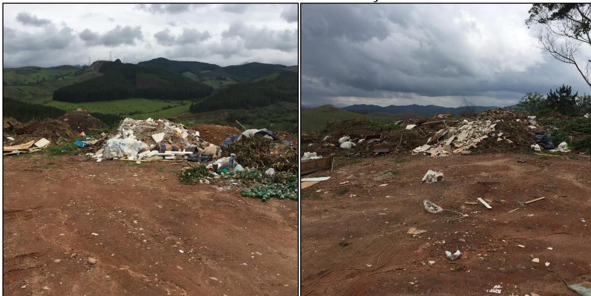
Figura 61 – Área não licenciada da Estação de Transbordo, com disposição final de resíduos da construção civil.
