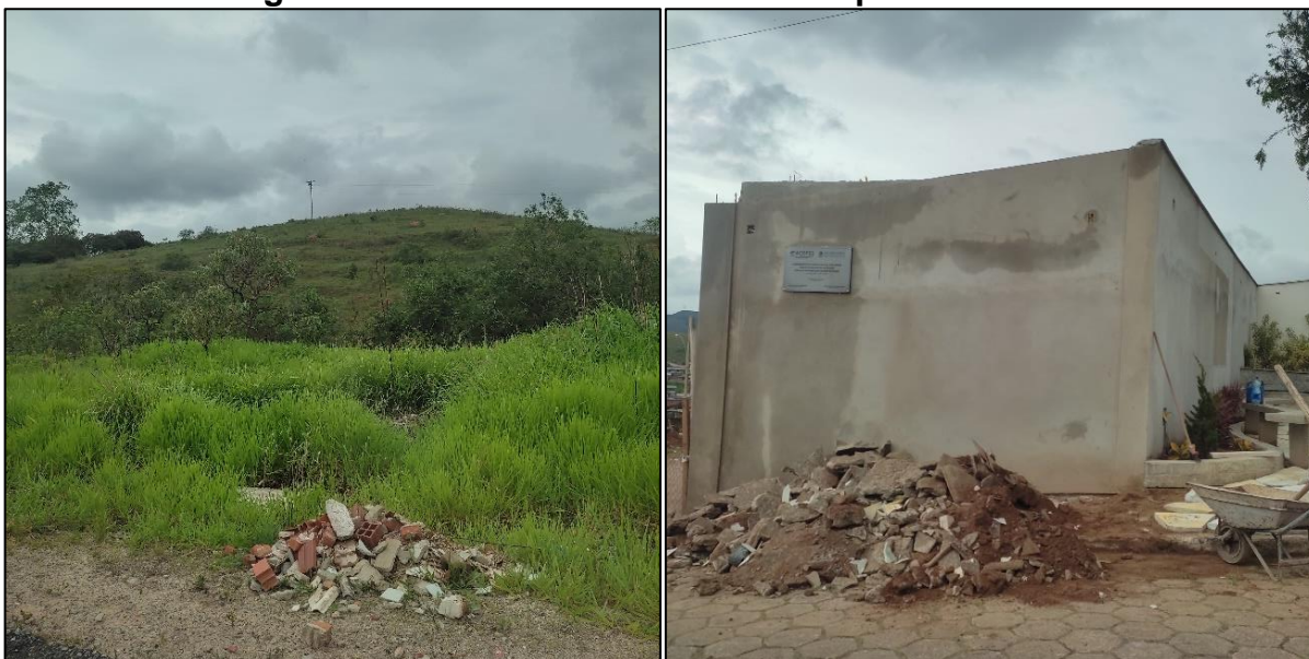
Figura 60 – Acondicionamento inadequado de RCC.
