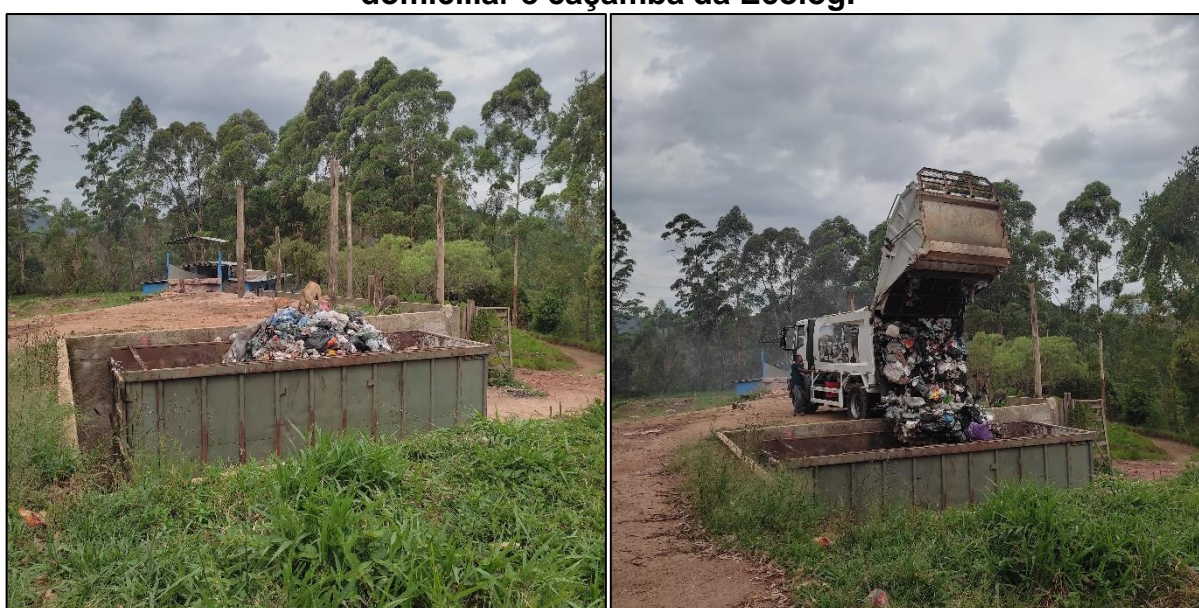
Figura 48 – Estação de Transbordo para recebimento dos resíduos da coleta domiciliar e caçamba da Ecolog.
